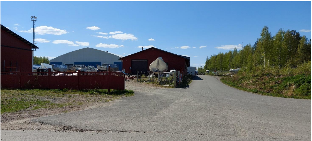
Telakka-alueen rakennuskantaa. Varastorakennukset ja katokset ovat rakennusmateriaaleiltaan vaihtelevia.
